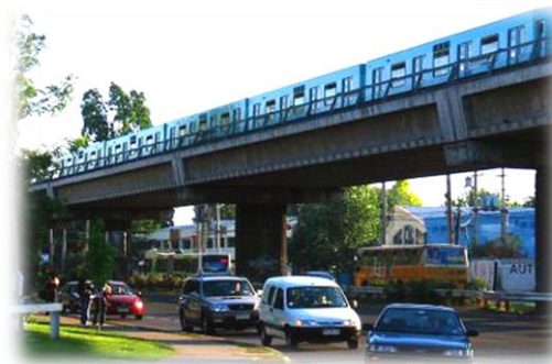
Línea 5 Viaducto Santiago de Chile
